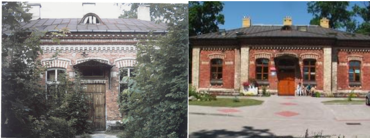
Budynek Środowiskowego Dom Samopomocy przed i po adaptacji
